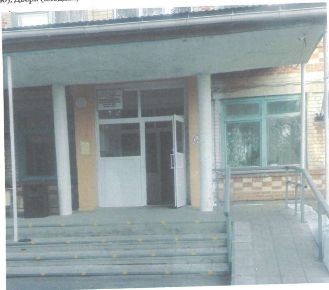
Фото № 2 Вход (входы) в здание; (Лестница (наружная); Входная площадка (перед дверью); Дверь (входная))
