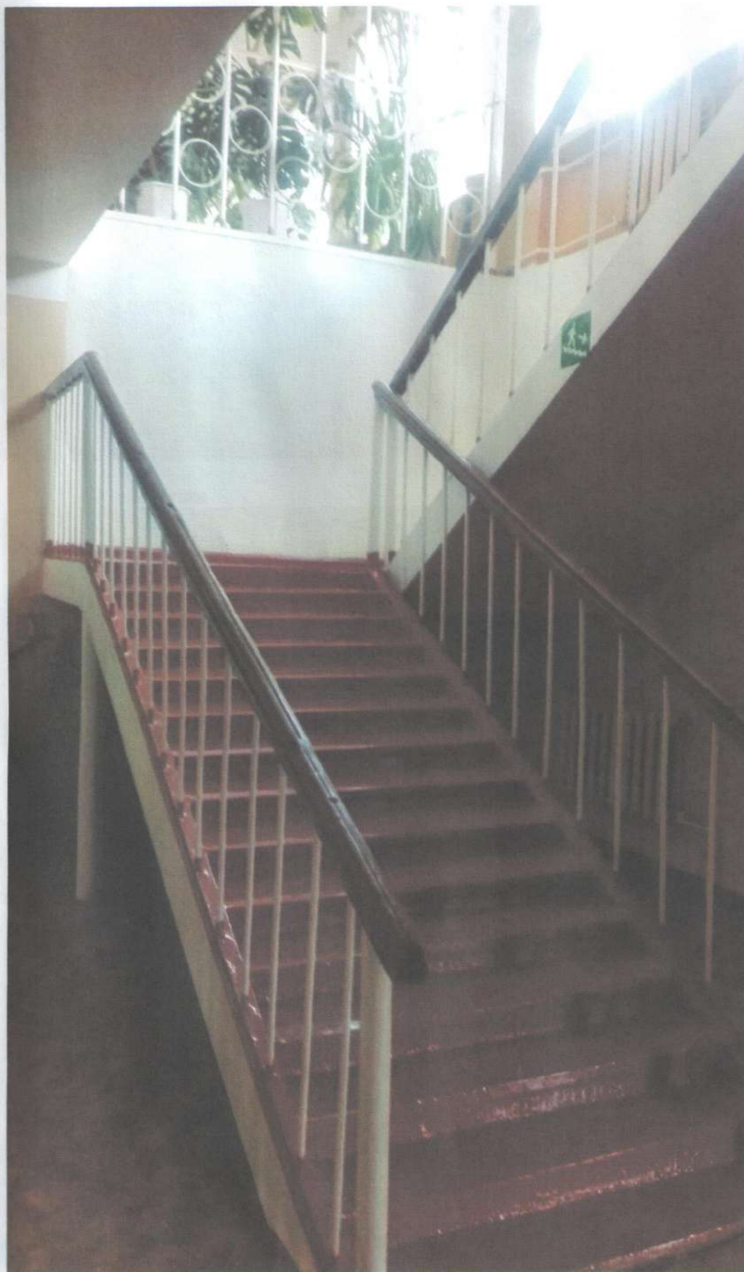
Фото № 13 Лестница (внутри здания)
